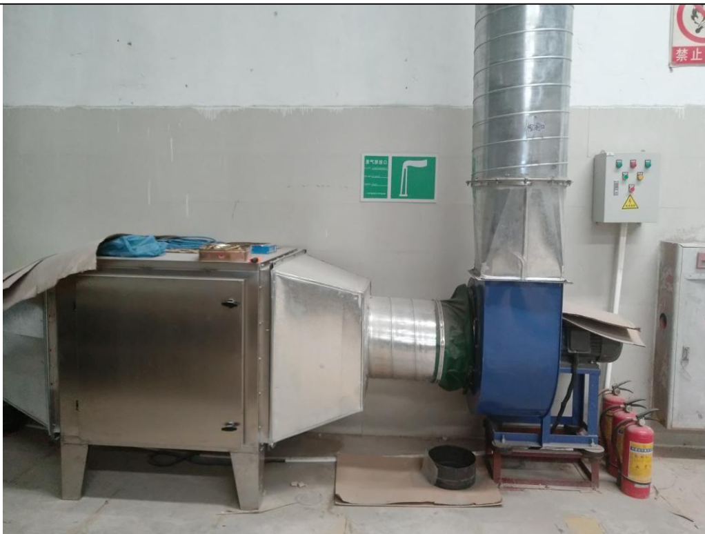
集气罩+活性炭净化器+排气筒
