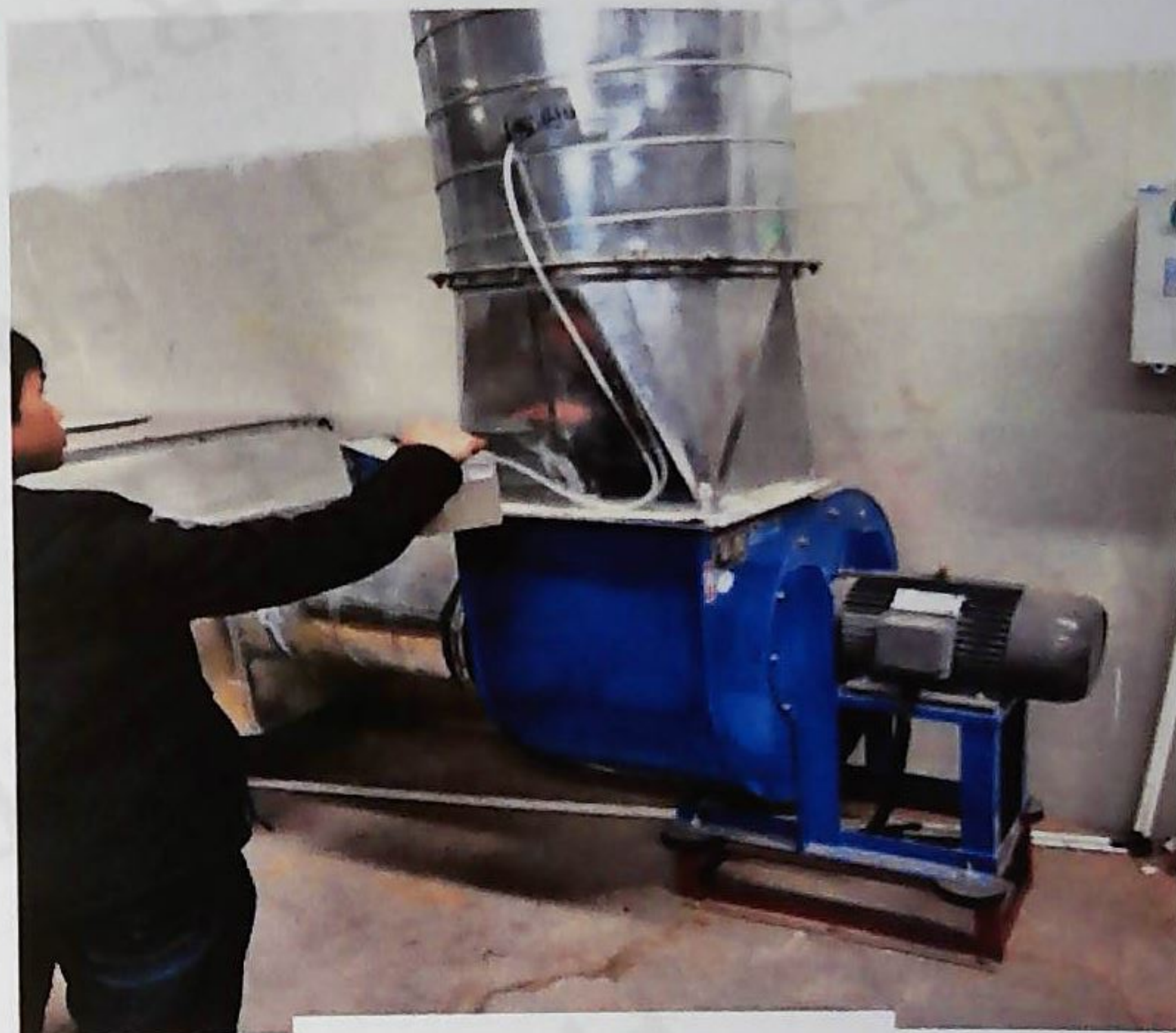
印刷工序废气排放口
